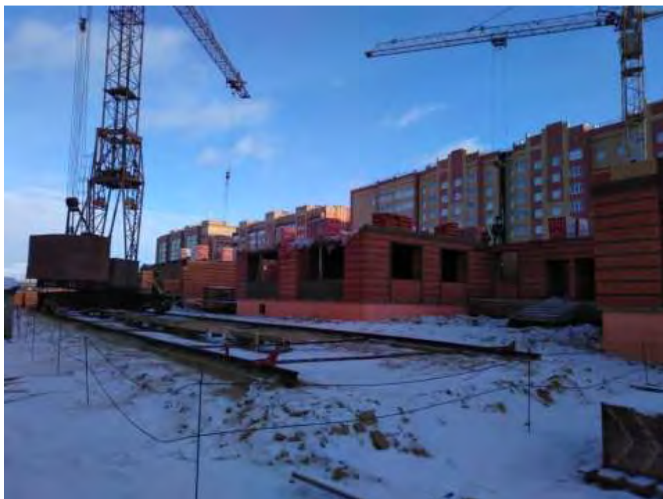
Строящееся здание детского сада в микрорайоне Молодежный, г. Йошкар-Ола
