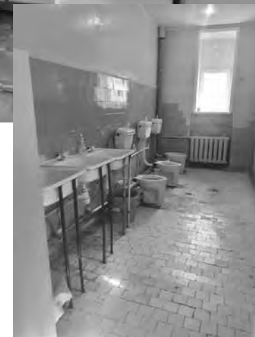
Туалетная комната в ПКБП №10
