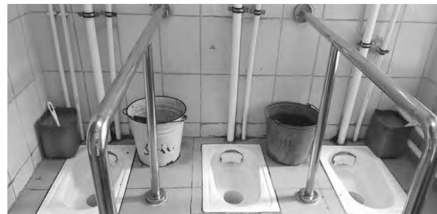
Туалетная комната, ПККПБ
