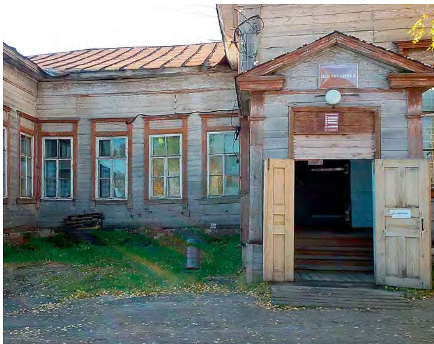
Поликлиника ГБУЗ Пермского края «Чердынская центральная районная больница» г. Чердынь
